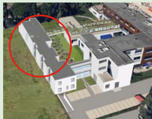
Implantation d'une nouvelle aile accrochée au bâtiment initial d'une superficie d'environ 1000m 2 sur deux étages – Septembre 2016.
