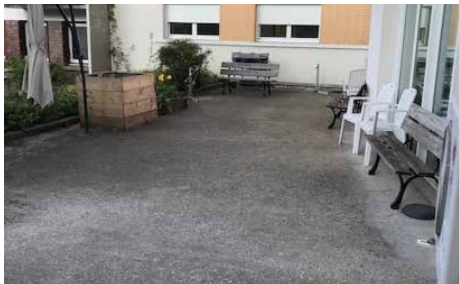
Terrasse avant les travaux
