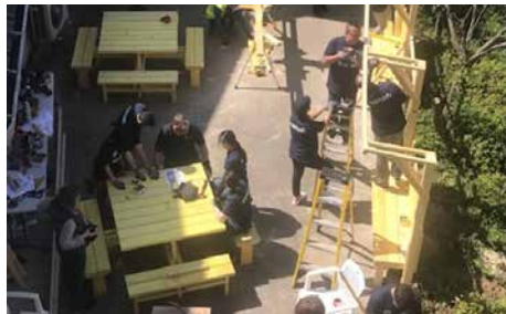
Terrasse pendant les travaux
